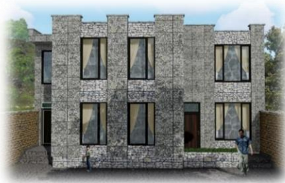
شکل ۸: مرحله تکمیل شده مسکن تدریجی با مصالح خشت پخته، خشت خام و سنگ و گابیون
